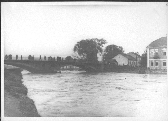
Nowy Sącz most na rz. Kamienicy w ciągu ul. Tarnowskiej - lipiec 1934 r.
